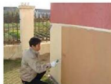
无机粉末涂料施工
