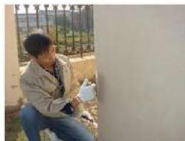
无机抗渗界面剂施工
