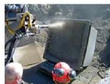
喷射混凝土
